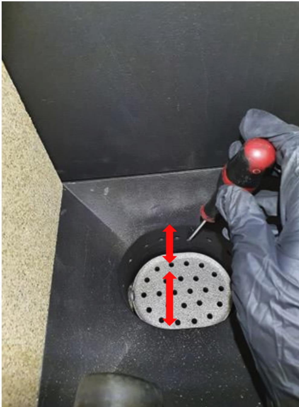
Gratter avec un tournevis, couteau la paroi du «trou» et la grille basculante pour que les croûtes de la suie ne collent pas de trop au fur à mesure des années
