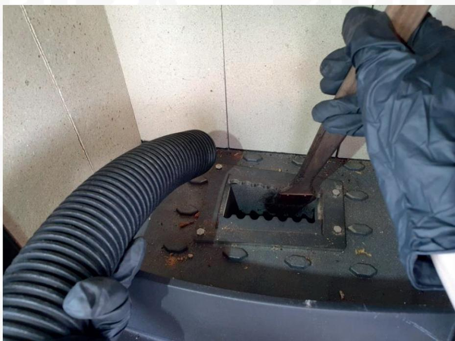
**Pour nettoyer la grille basculante du mieux possible à cause de l'accès difficile, s'aider avec le pinceau, gratter avec un tournevis par exemple**
